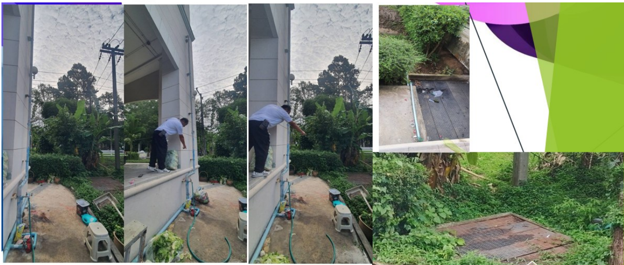
ใช้ระบบบำบัดน้ำเสียร่วมกับของมหาวิทยาลัยด้วยระบบเอสบีอาร์ (Sequencing Batch Reactor, SBR)
