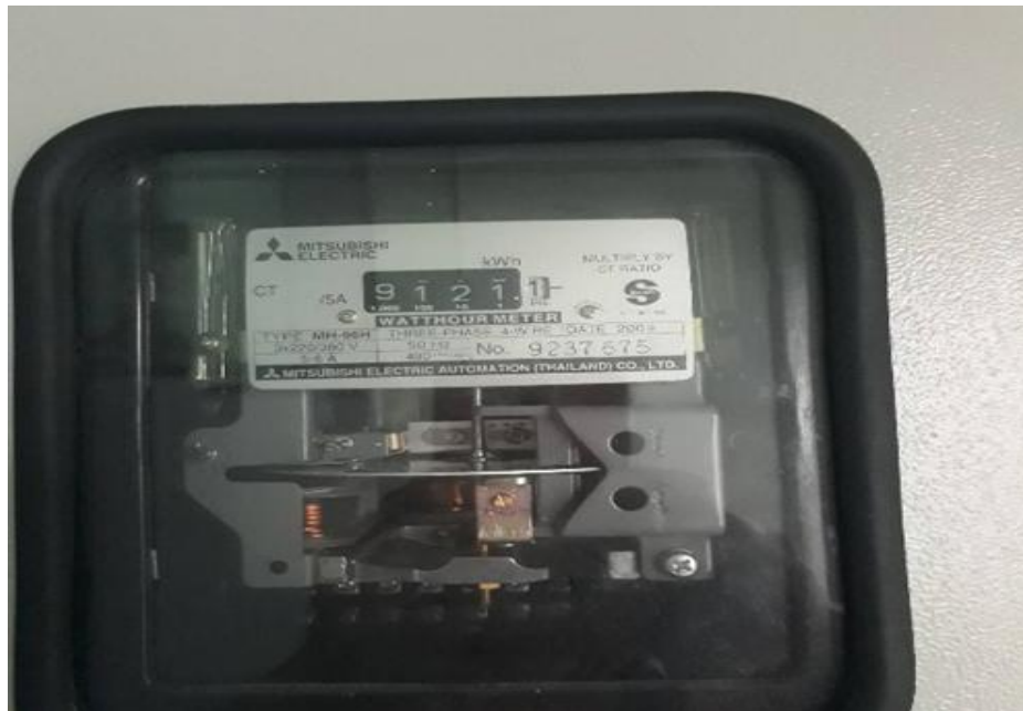
ภาพที่ ๒ วิทยาลัยมีมิเตอร์ไฟฟ้าแยกชัดเจน และมีการจดบันทึกข้อมูลปริมาณการใช้ไฟฟ้ารายเดือน
